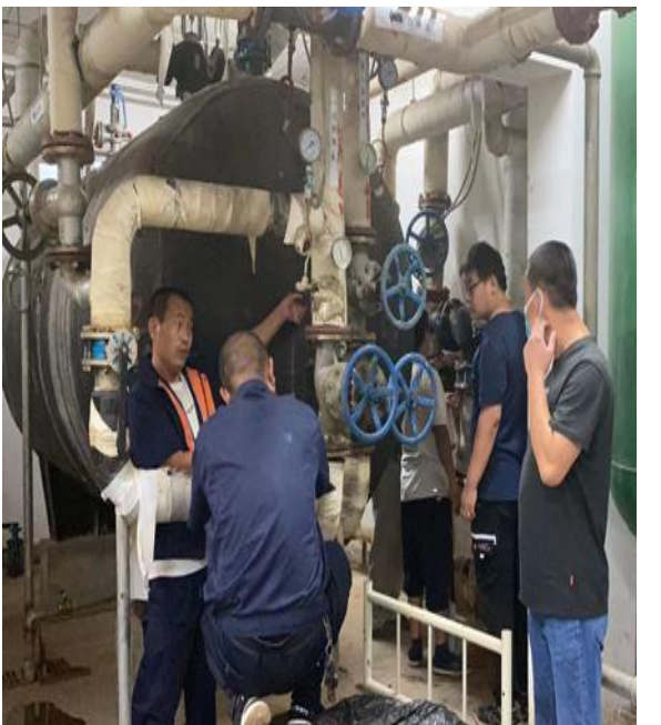
维修 3C 交换站电动阀
