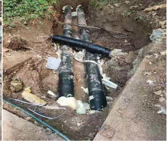
管道防腐保温
