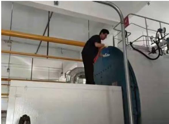
锅炉刷漆保养
