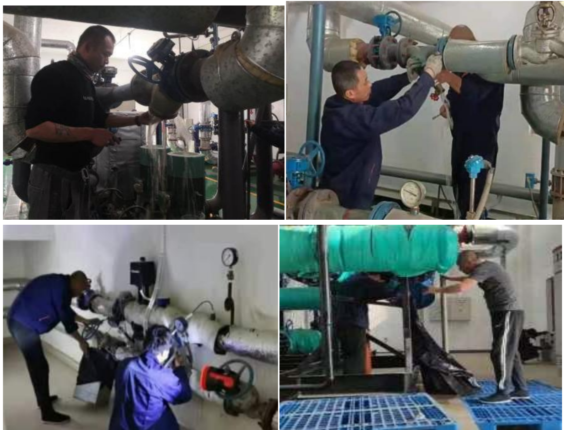
冲洗供暖过滤器
