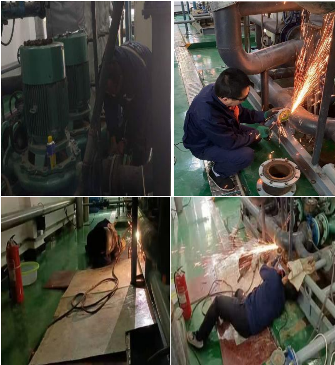
更换 2#供暖交换站生活区软连接 4 台
