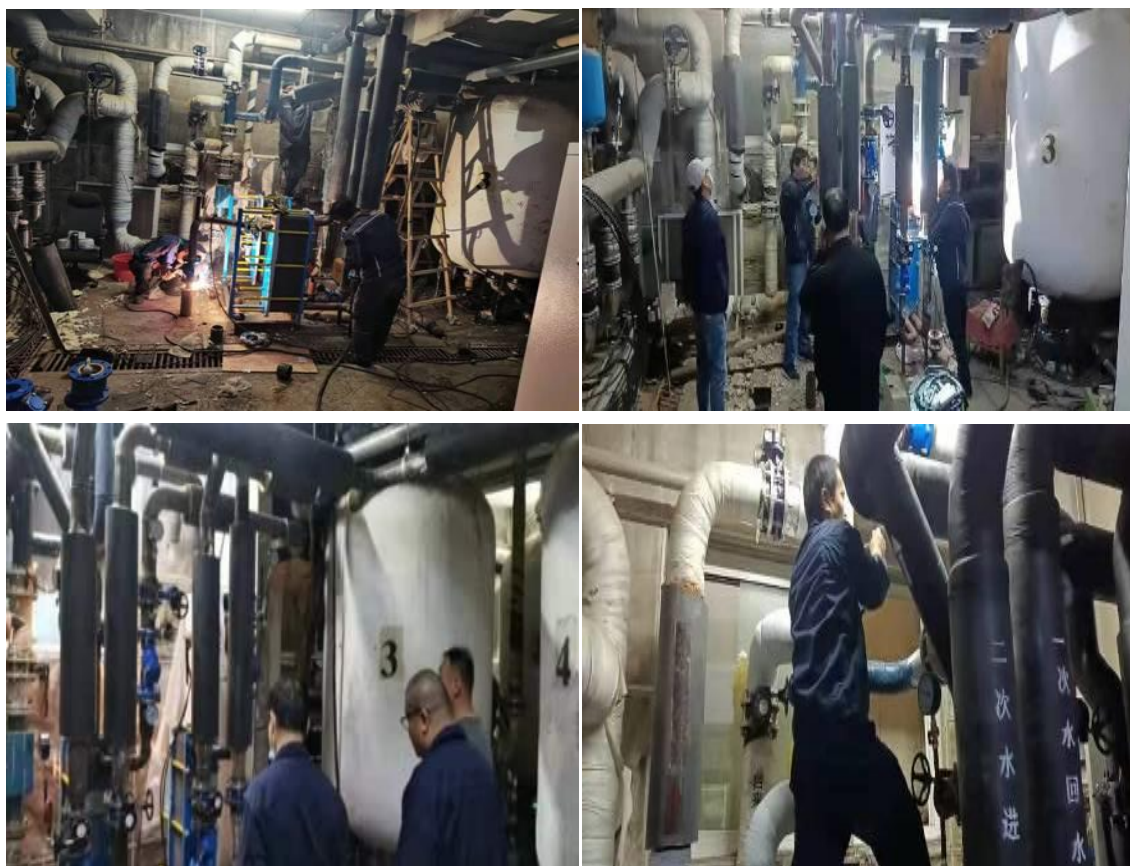
协助静园 D 板式换热器增容施工
