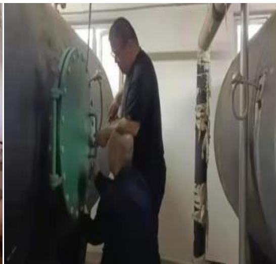
修复后安装换热罐
