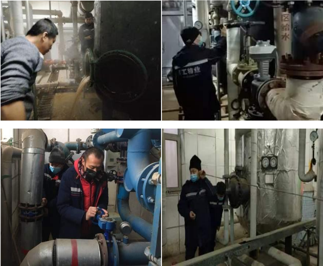
排查供暖供热所有交换设备运行情况
