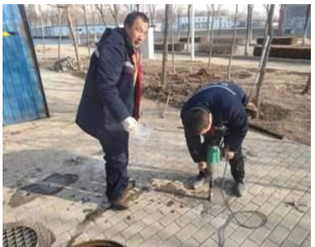
勘探动力中心地下漏水管道 敷设环境，拟定维修方案
