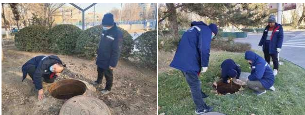
排查直埋热力管道是否异常
