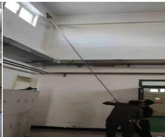
西区锅炉房清扫房顶
