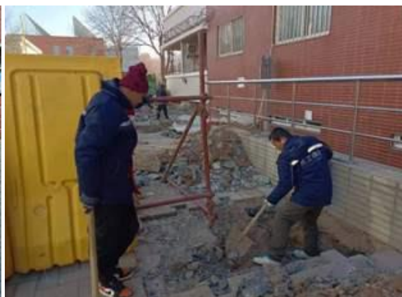
人工挖掘漏水管道
