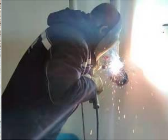
暖气管道焊接安装
