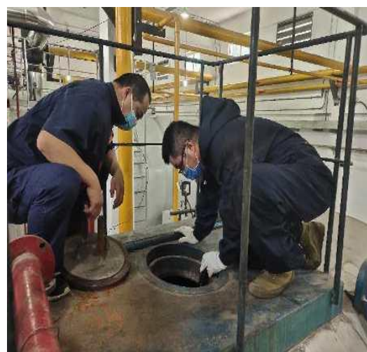
锅炉锅筒内部检测
