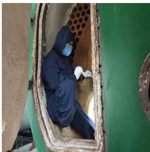
锅炉内部管板检查
