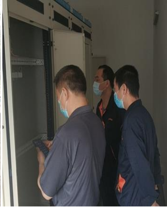
指导配电柜检修工作
