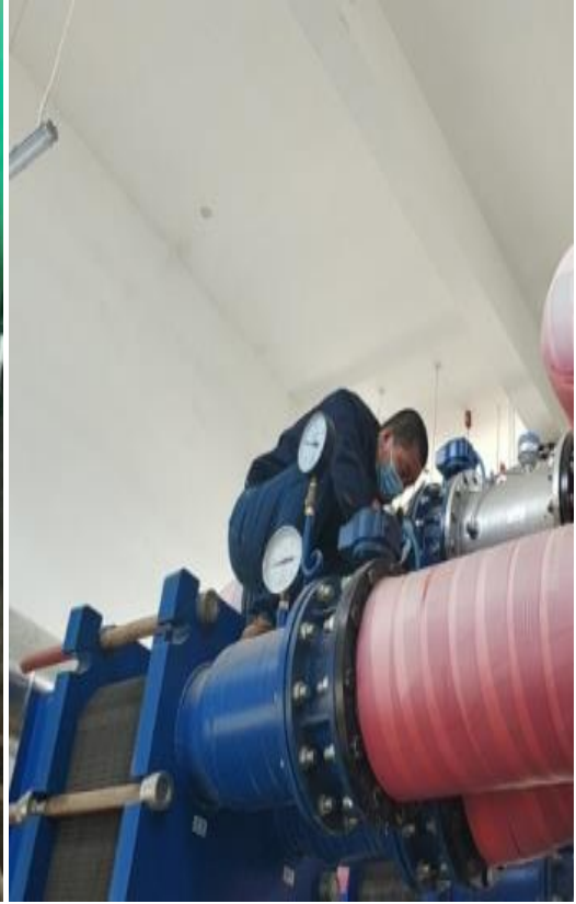
拆除交换站回水过滤器
