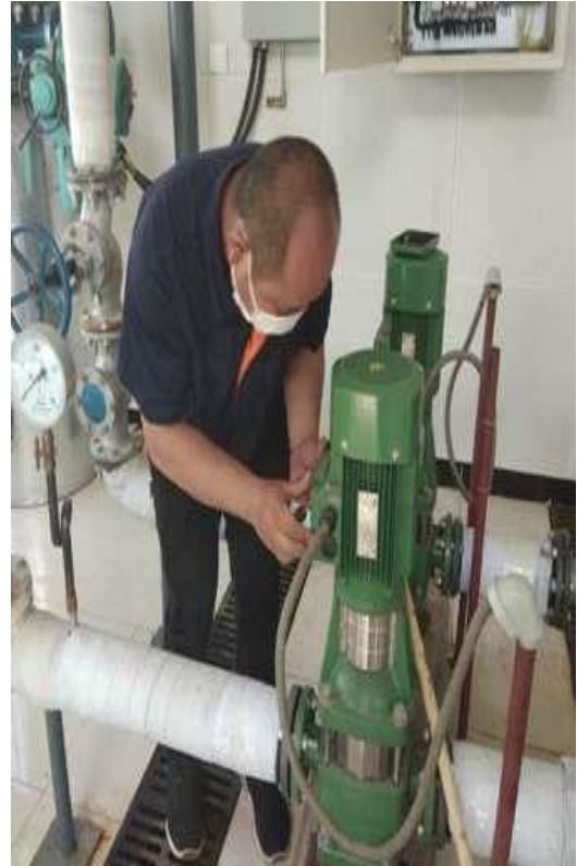
循环泵、补水泵绝缘检测
