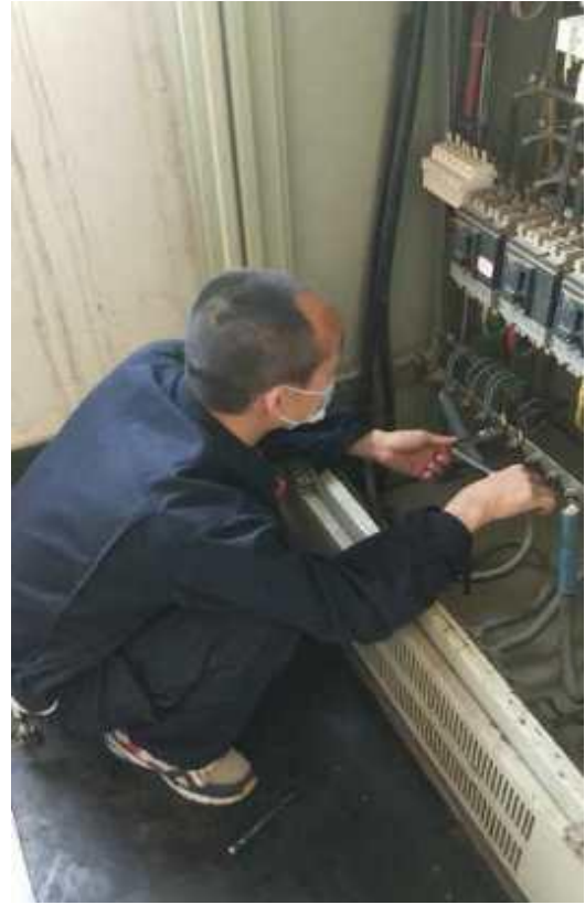
配电柜线路检修紧固接线端子
