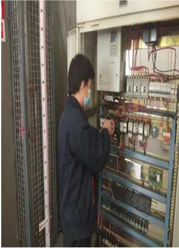
配电柜线路检修紧固接线端子
