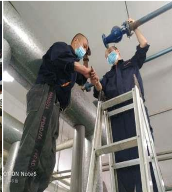
更换锅炉超压泄水电磁阀
