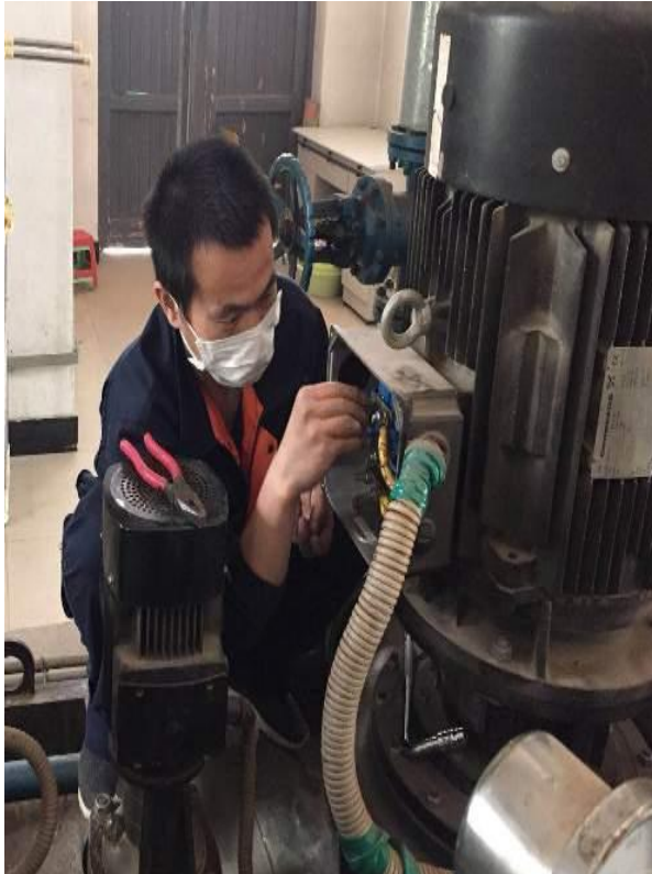
循环泵、补水泵绝缘检测
