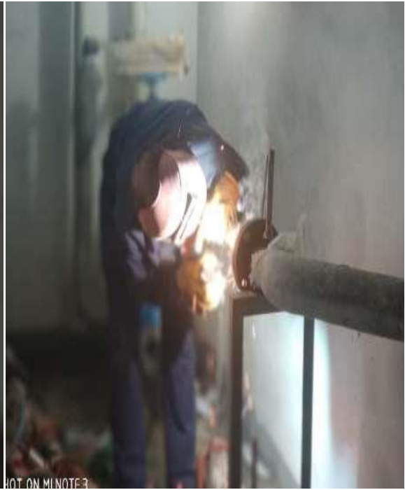
法兰管道焊接
