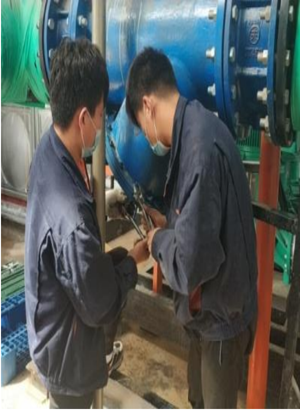
拆除交换站回水过滤器
