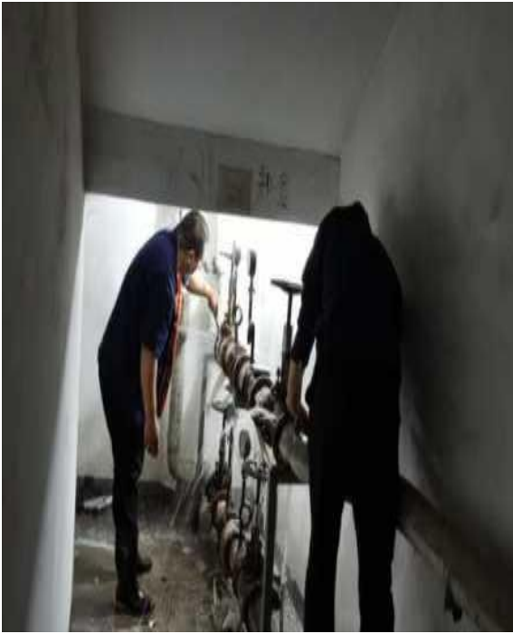
拆除旧管道及阀门
