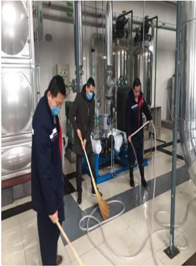
东区锅炉房交换站清扫
