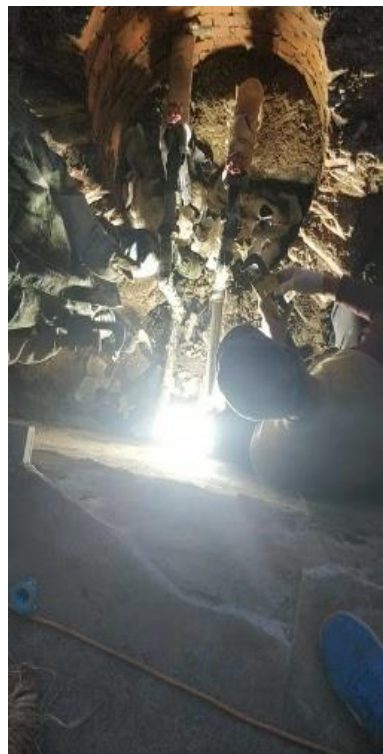
连夜抢修施工
