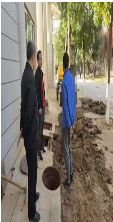
南区操场看台西侧施工
