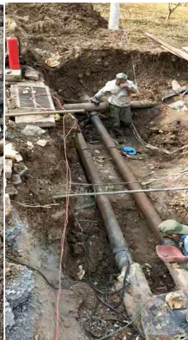
管道焊接维修完成
