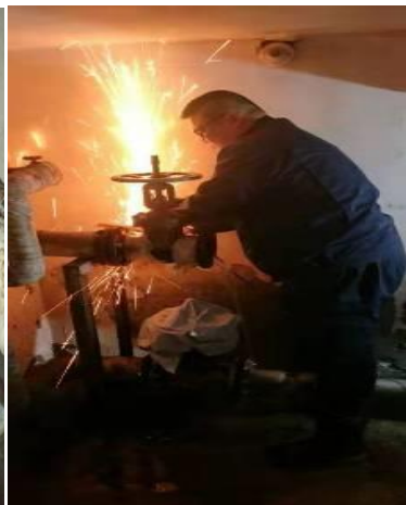
拆除腐蚀管路和阀门
