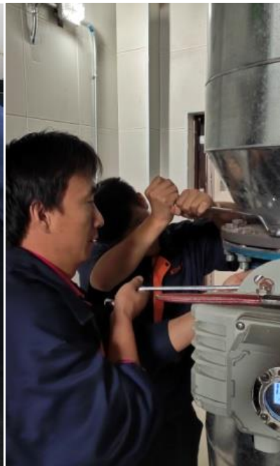
电动阀漏水维修
