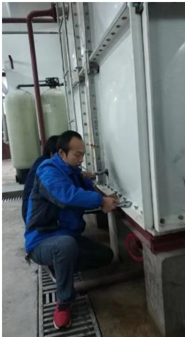
生态楼水箱维修
