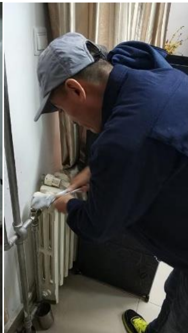
暖气漏水维修
