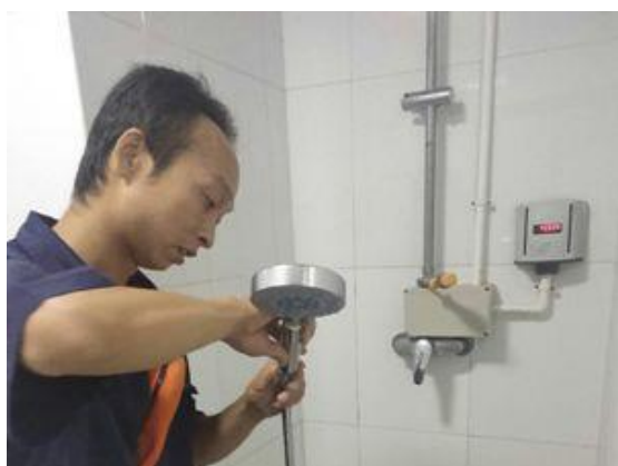
淋浴设备维修
