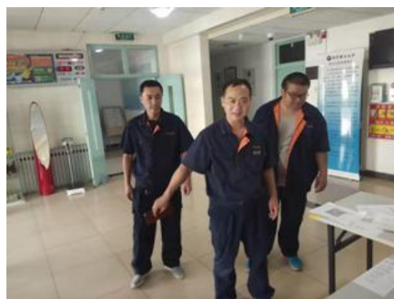
进入迎新楼巡视供热设备
