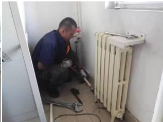
暖气管路优化施工
