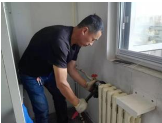
暖气管路优化施工
