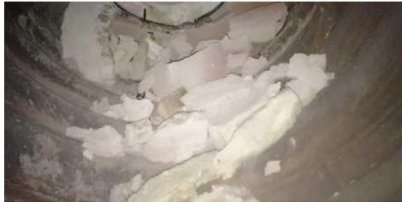
4#炉内部保温层脱落
