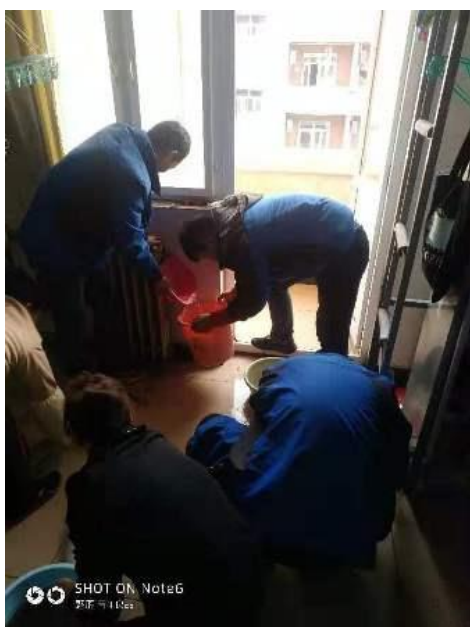
学生宿舍暖气漏水维修
