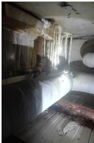
疏桐园 E 地下浴室
