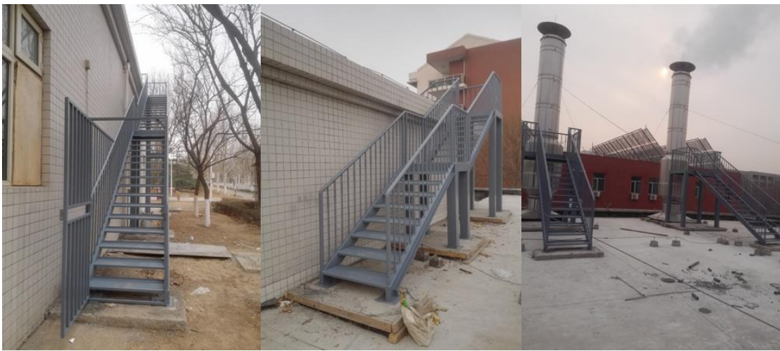
修建三段楼梯
