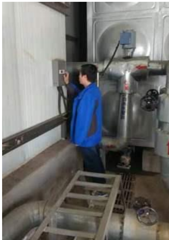
太阳能控制系统调试
