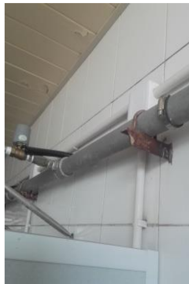
疏桐园 E 四层浴室
