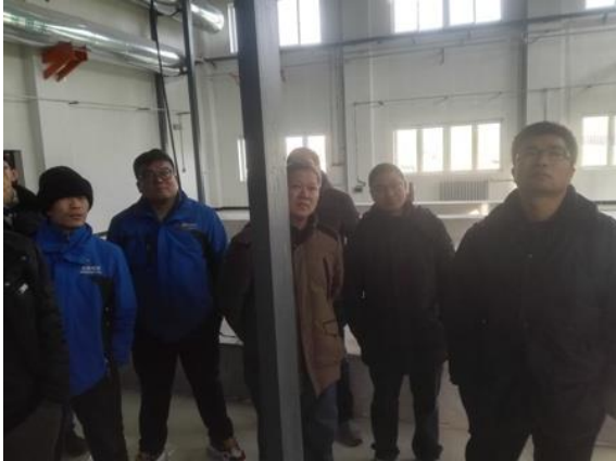
锅炉运行验收
