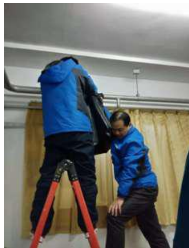
施工应急防护
