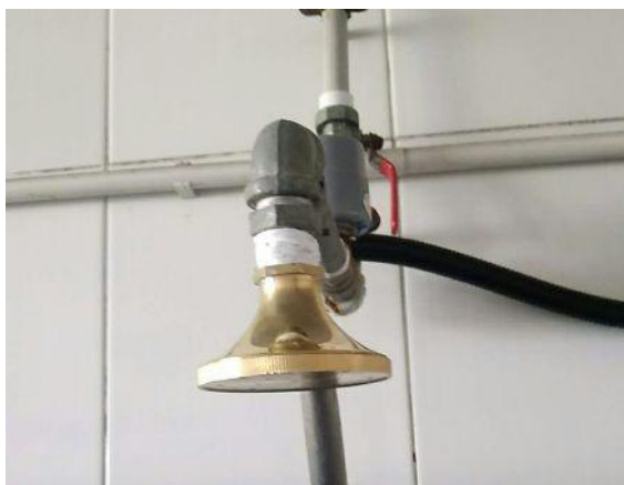
喷头损坏更换
