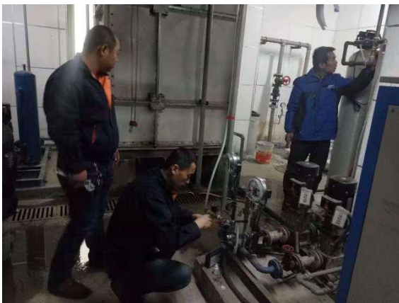
供暖交换站设备调试
