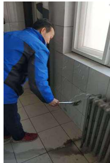
放气阀漏水维修
