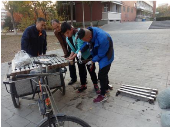
暖气片漏水维修
