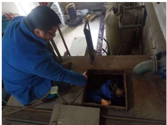
水箱水位控制维修
