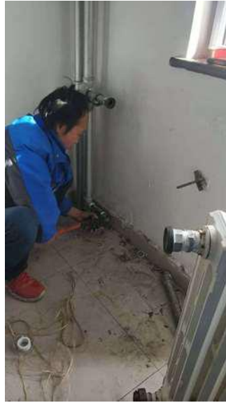
暖气维修安装
