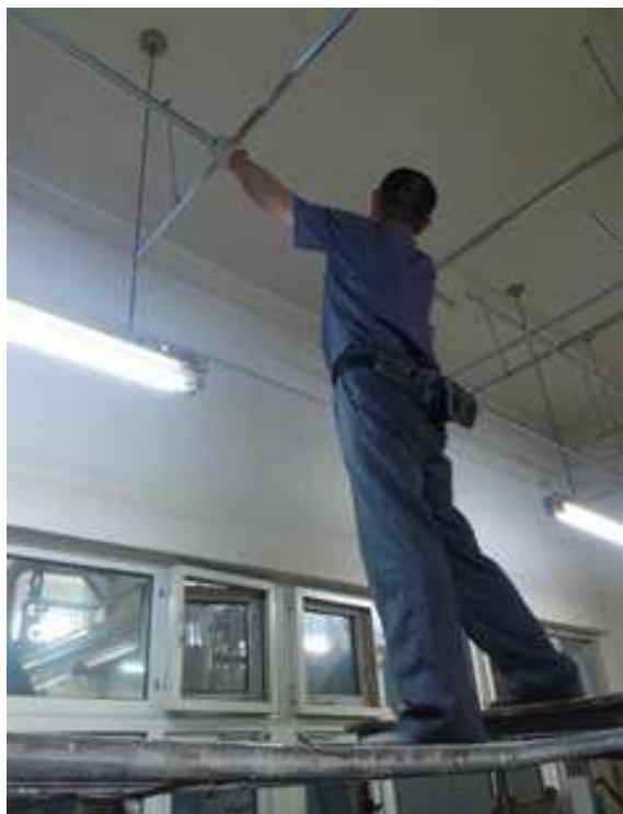
控制室吊顶工程
