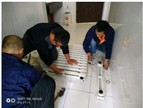
修复暖气片漏水
