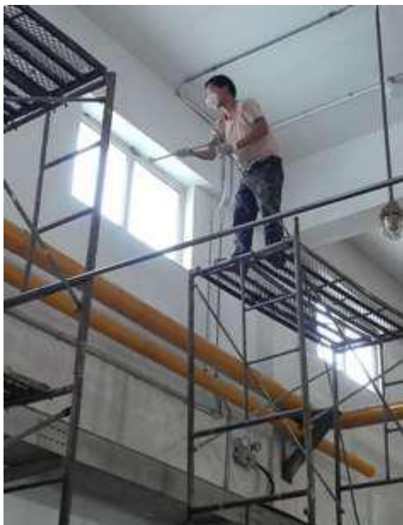
锅炉房粉刷工程
