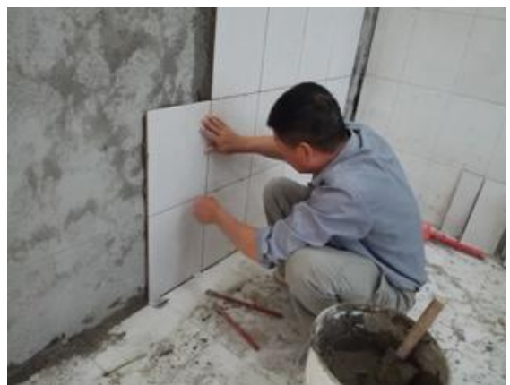
部分墙地砖修复
