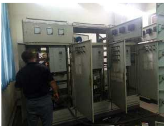
电器设备除尘
