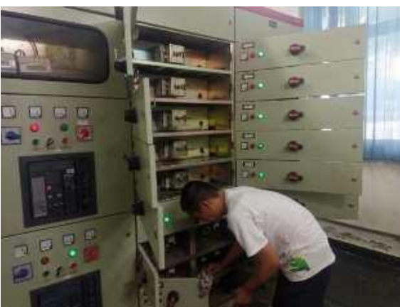
配电柜清扫除尘
