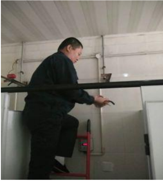
淋浴设备维修
