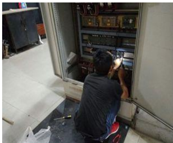
紧固接线端子
