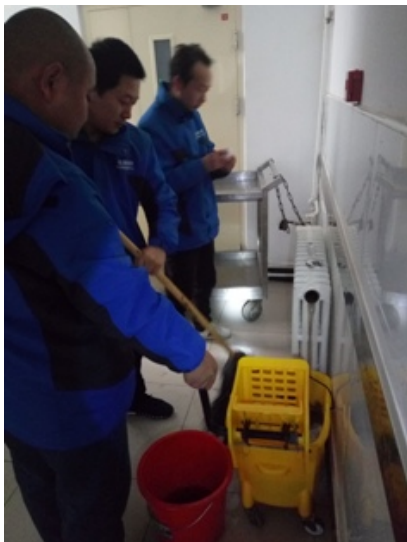
2#食堂暖气冲洗（堵塞）
