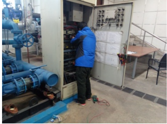
更换图书馆一次水控制柜变压器
