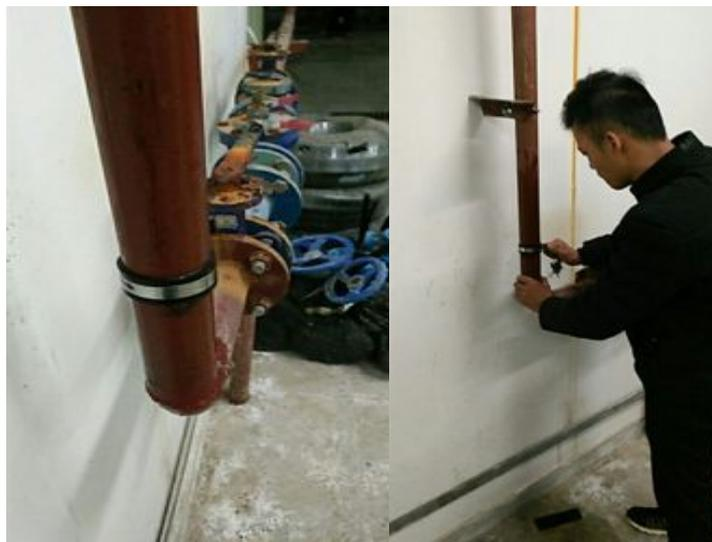
自来水管管道漏水临时处理
