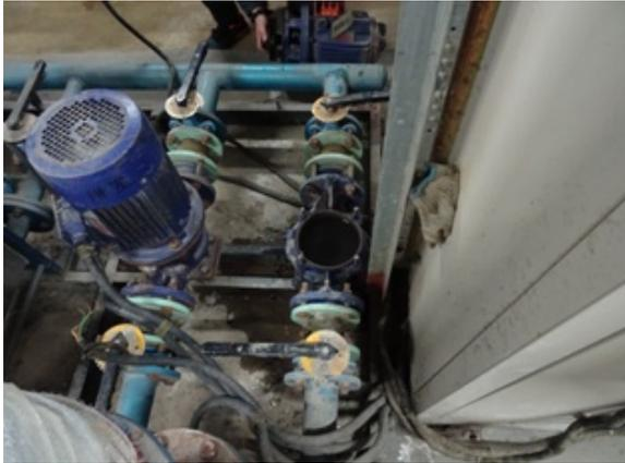
拆卸、维修循环泵
