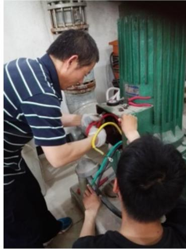
一次水循环泵电缆改造
