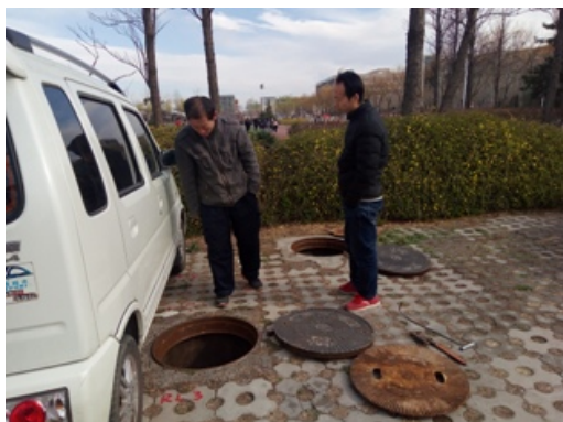
南大门管道井抽水排查漏水点
