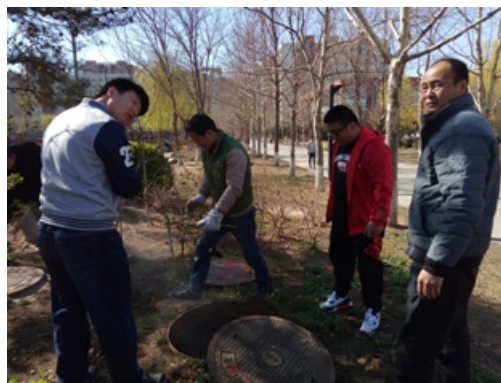
足球场东南角管道井抽水排查漏水点
