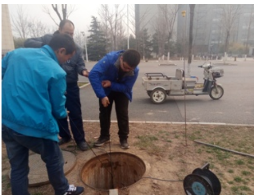
足球场东南角管道井抽水排查漏水点
