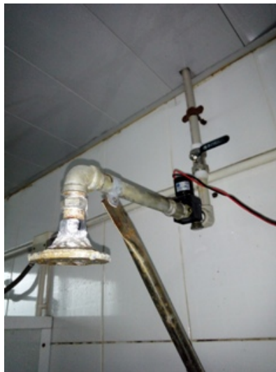
静园 A 喷头结垢老化
