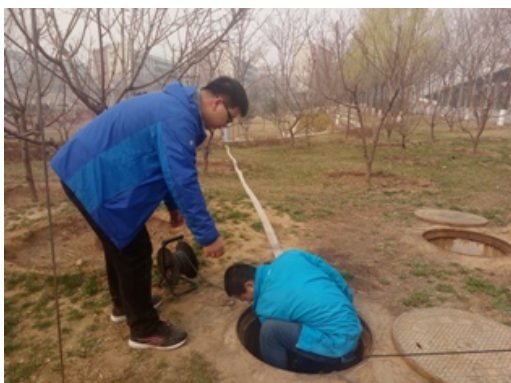
南大门管道井抽水排查漏水点
