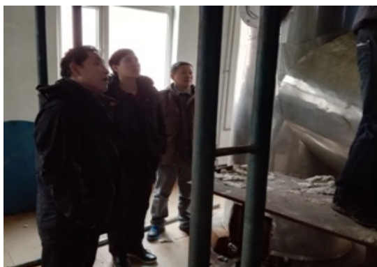
中心主任查看锅炉故障情况
