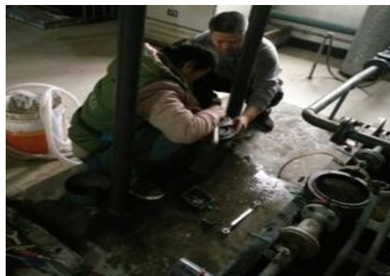
修供暖补水泵
