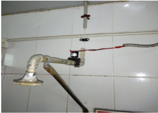
更换洗浴间热熔阀门
