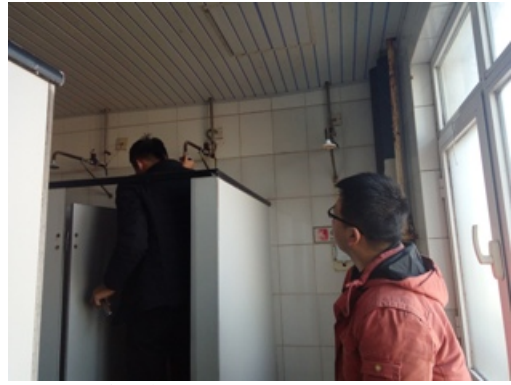
静园洗澡系统排气、试运行调试
