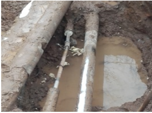
静园 D 栋修复后的洗澡水管道
