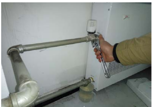
多处暖气及管道漏水
