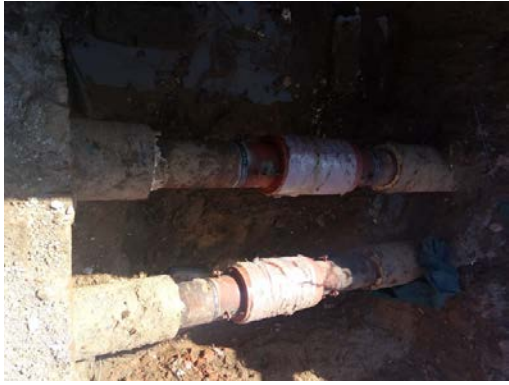
伸缩器焊接完成
