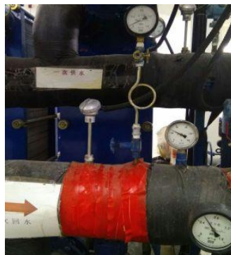
供暖交换站水处理设备及部分温控、压力保障设备
